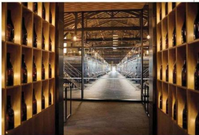
En bas puis en haut : depuis la cave, longue de 108 mètres, le vin est transféré, souterrainement et par gravité, dans le chai enterré, dédié au stockage et à l'embouteillage.
